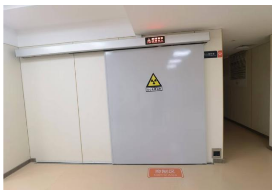
照片10 患者通道防护门、工作状态指示灯、电离辐射标识及中文警示
